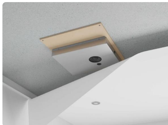
Montaż za sufitem napinany
